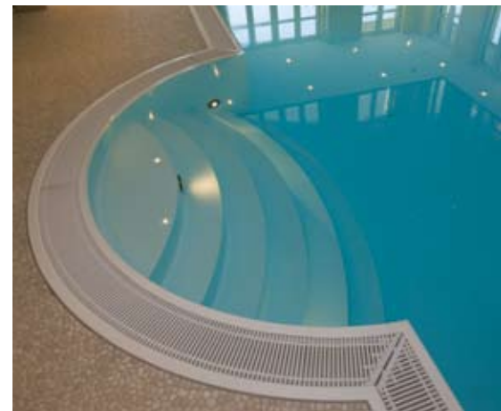
Großzügiger Treppeneinstieg auf der Längsseite des Schwimbeckens.
